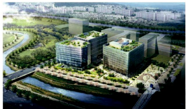
N-Square 520RT 3units, 370RT 2units
